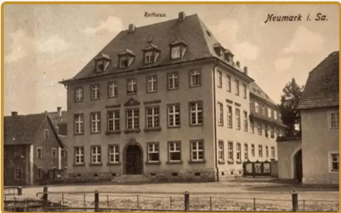
Rathaus Neumark – dieses 1928 auf dem Marktplatz eröffnete Gebäude spiegelt das Wachstum und den Bürgersinn der Gemeinde im frühen 20. Jahrhundert wider. Es ist bis heute ein zentrales Wahrzeichen und Verwaltungszentrum Neumarks. Gemeinsam mit den historischen Marktgebäuden und der Kirche steht es für die Verbindung von Tradition und Fortschritt im Ort.
